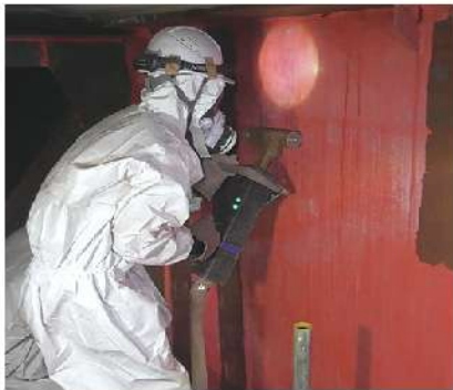
IH装置で鋼板を加熱
