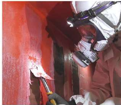
スクレーパーで塗膜を剥離
