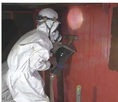
IH装置で鋼板を加熱
