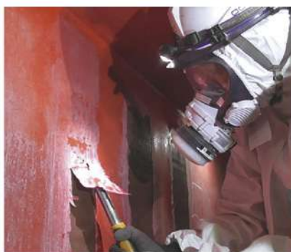
スクレーパーで塗膜を剥離
